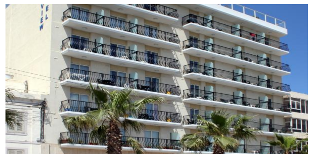
Aussenansicht Sliema Schulresidenz
